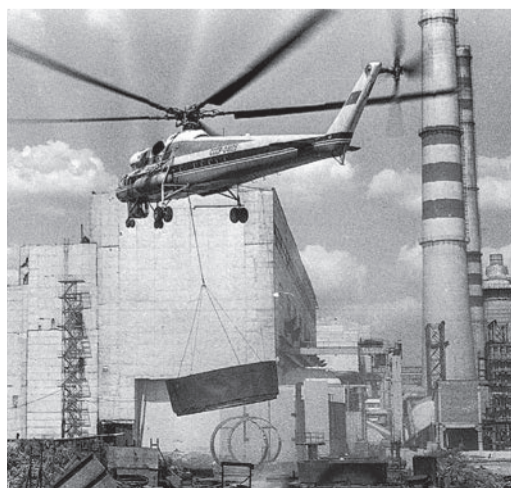
Монтажные работы на Киришской ГРЭС
